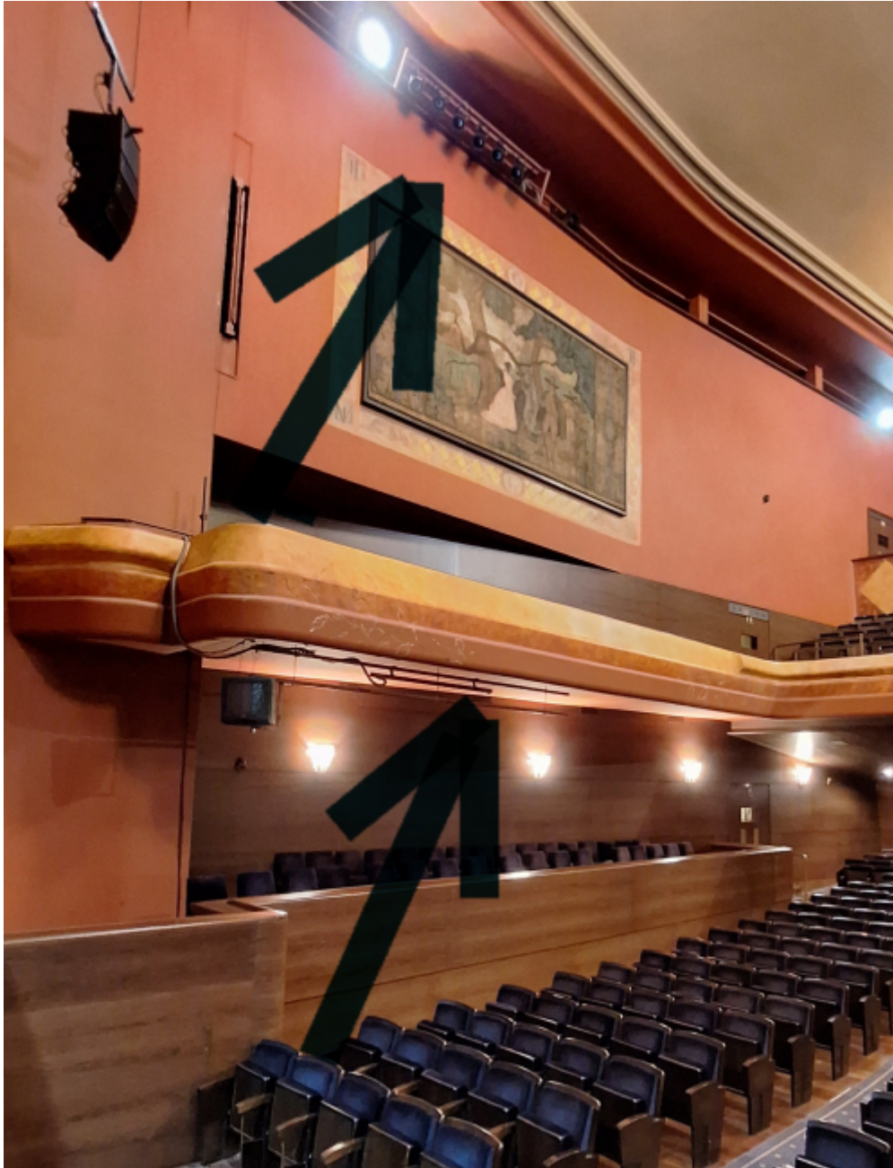
Cerchas para colocación de focos laterales.
